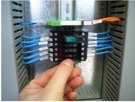
Figure81:Replacing fuses 更换熔断器
