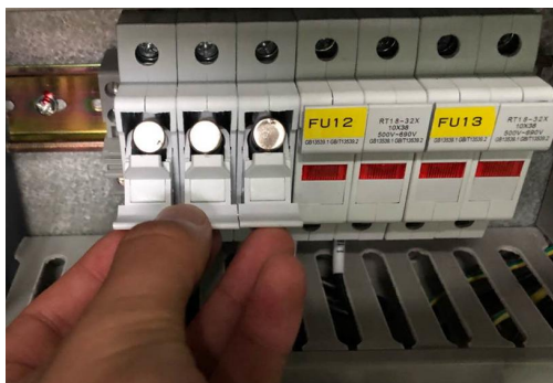
Figure80:Replacing fuses 更换熔断器
