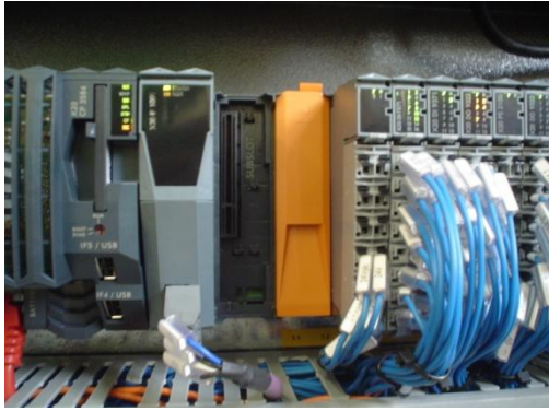
Figure57:Profibus module connection Profibus 模块连接
